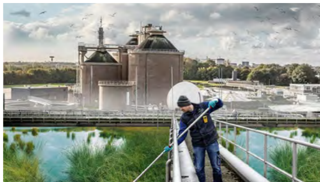
Nazuivering van effluent in een groene 'waterharmonica'
